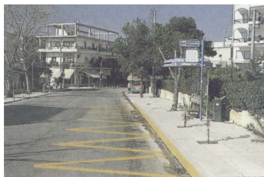
Εικόνα 2.2: Τεθλασμένη γραμμή στο άκρο του οδοστρώματος.
