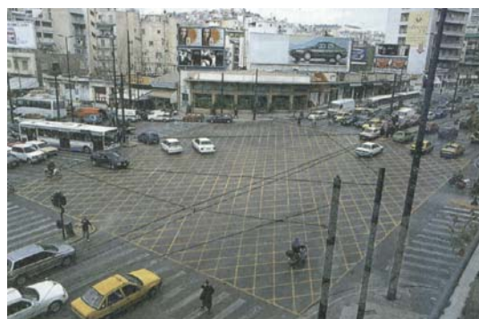
Εικόνα 2.4: Πλέγμα γραμμών σε πολυσύχναστο ισόπεδο κόμβο. Η είσοδος στην περιοχή απαγορεύεται εάν το όχημα πρόκειται να παραμείνει εκεί.
