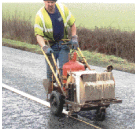
Εικόνα 2.8: Χειροκίνητος μηχανισμός έγχυσης θερμοπλαστικού υλικού.
