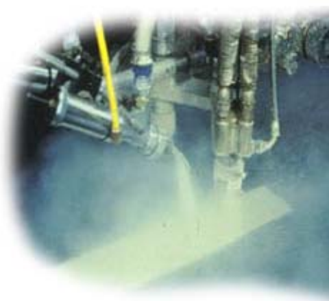
Εικόνα 2.11: Εφαρμογή θερμοπλαστικής διαγράμμισης με ψεκάσμο. Διακρίνεται και η διασπορά των γυάλινων σφαιριδίων.
