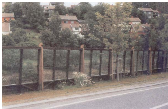
Εικόνα 8.4: Διαφανές ηχοπέτασμα με ξύλινα στοιχεία, για περιορισμό της αλλοίωσης της άποψης του περιβάλλοντος.
