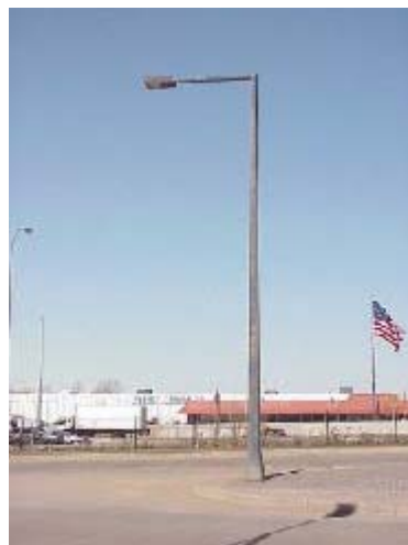
Εικόνα 7.10: Στύλος φωτισμού με ευθύγραμμο βραχίονα.
