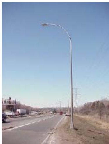
Εικόνα 7.9: Στύλος φωτισμού με καμπύλο βραχίονα.
