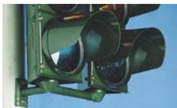
Εικόνα 5.7: Στερέωση με βραχίονα με επέκταση.
