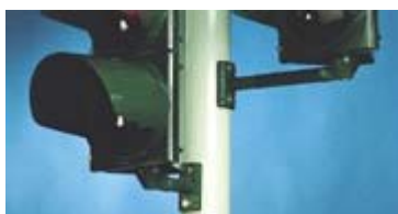
Εικόνα 5.6: Αριστερά στερέωση με απλό βραχίονα και δεξιά με βραχίονα προέκτασης.
