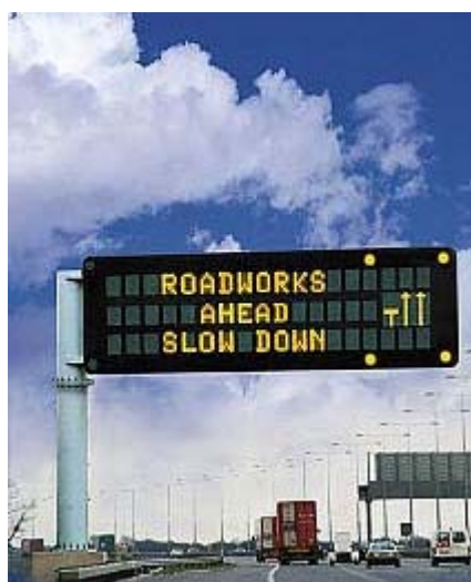
Εικόνα 4.1: Πινακίδα VMS σε γέφυρα σήμανσης επάνω από το οδόστρωμα.
